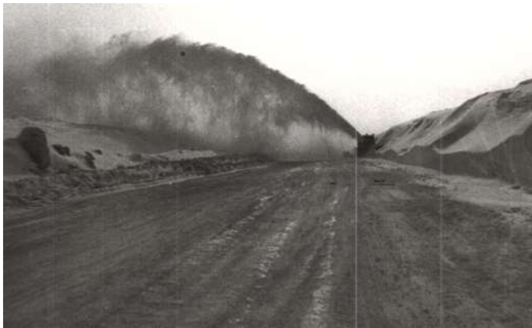
Новая дорога Ира-Мраково. Роторный снегоочиститель в работе.
